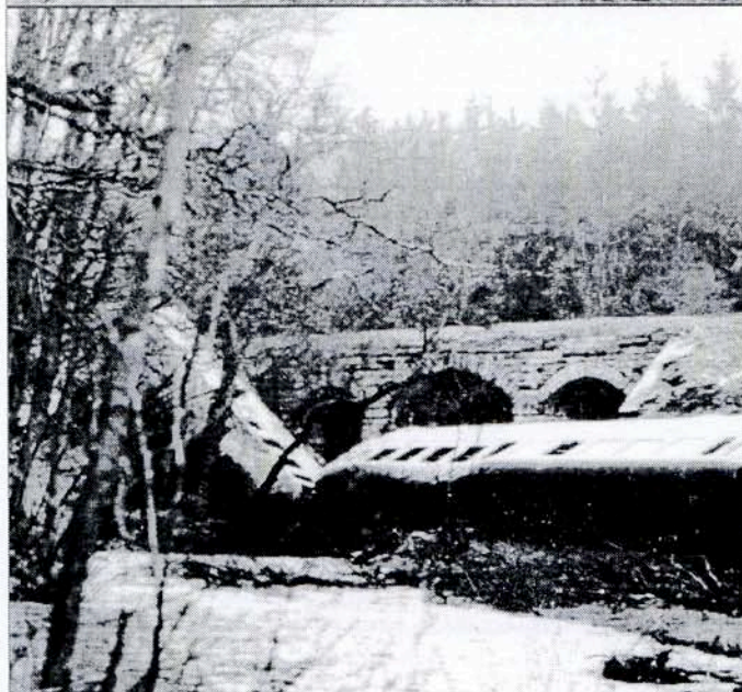
En haut : la locomotive dans le fond du ravin photographiée avant les travaux de relevage.
